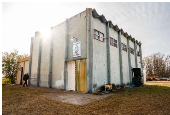
Vista exterior de la Planta Piloto
